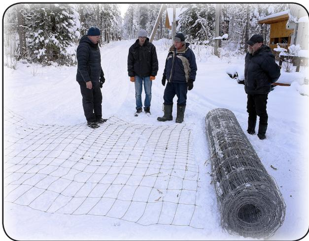
Демонстрация сетки с фиксированным узлом
