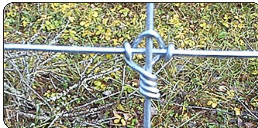
ограждения до 40 лет. При необходимости часть опор может быть заменена без нарушения целостности всего ограждения и расстояние между опорами может быть до 5-6 м, что почти на 30-40% превышает рекомендованное расстояние между столбами при установке сетки Рабица. Установка ограждения производится с помощью специального крепежа. Данное ограждение выдерживает падение достаточно крупных деревьев без разрыва полотна сетки. Если сетка все-таки повреждена, ее можно легко и быстро восстановить.
